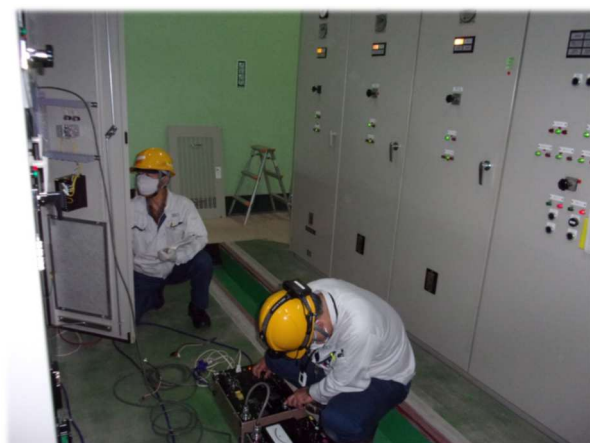
污水ポンプ場の水位を確認する盤の更新、動作確認(電気工事)
