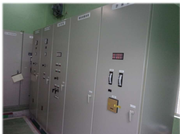
污水ポンプ場の水位を確認する盤の更新、動作確認(電気工事)
