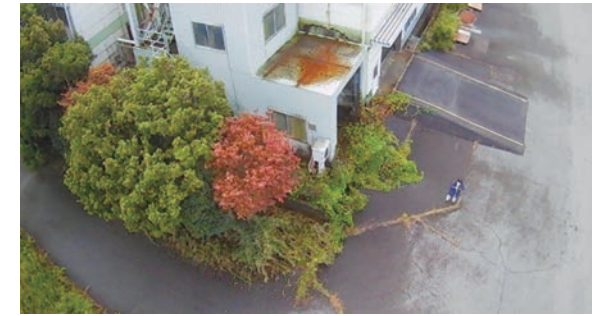
上空から污泥焼却灰焼成棟を撮影した画像
